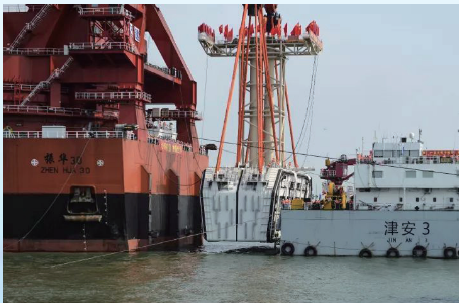
△ 2017年5月2日，港珠澳大桥沉管隧道吊装进入海底
